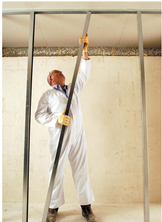
Inserting Knauf Acoustic 'C' Studs
