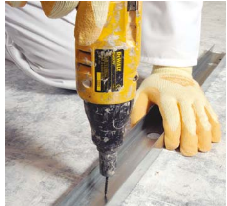
Fixing Knauf 'U' Channel
