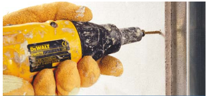
Fixing Knauf Aquapanel using Knauf Aquapanel Maxi Screws
